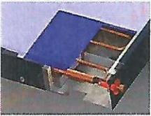
12 Τοποθετούμε τον συλλέκτη επάνω στα ελάσματα συγκράτησης του συλλέκτη. Βιδώνουμε σταθερά την εγκοπή του συλλέκτη στο έλασμα συγκράτησης του συλλέκτη. Αλφαδιάζουμε το σύστημα και προχωράμε στην υδραυλική συνδεσμολογία όπως δείχνει η παρακάτω φωτογραφία.
